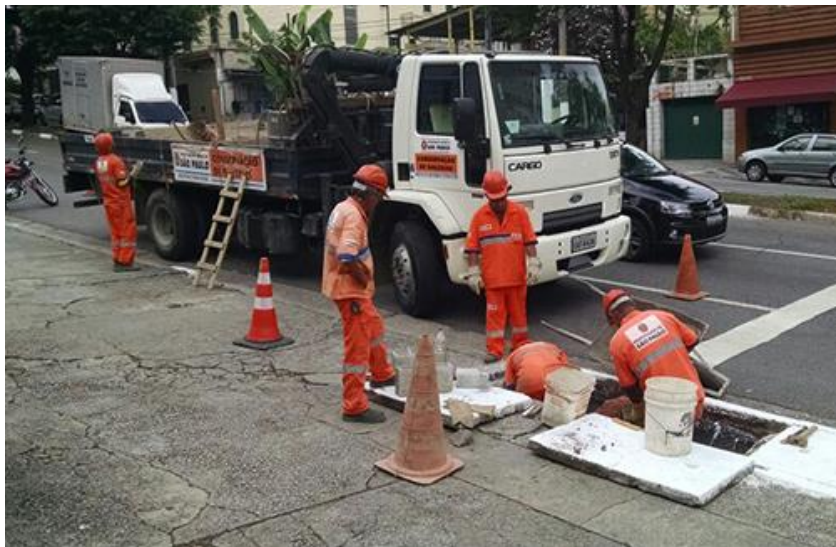
Legenda: Exemplo de Serviço de Drenagem
